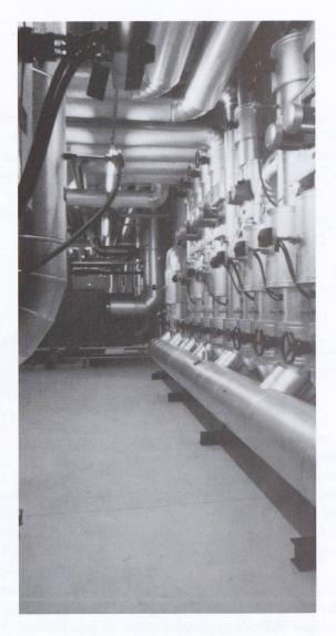
Il fabbisogno termico di base viene coperto dalla pompa termica la quale fornisce altresì la necessaria energia frigorifera.
