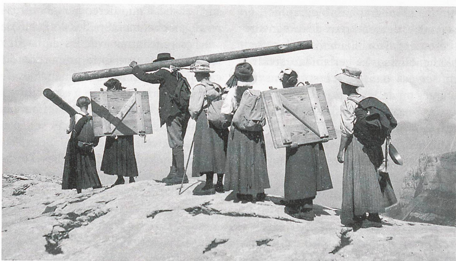
Construction de la cabane de Pierredar, 1908.
