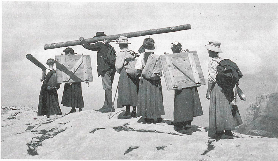
Construction de la cabane de Pierredar, 1908.
