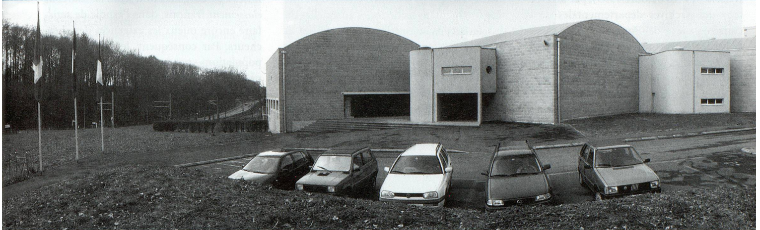
Le bâtiment des Archives cantonales vaudoises, à Chavannes-près-Renens.
