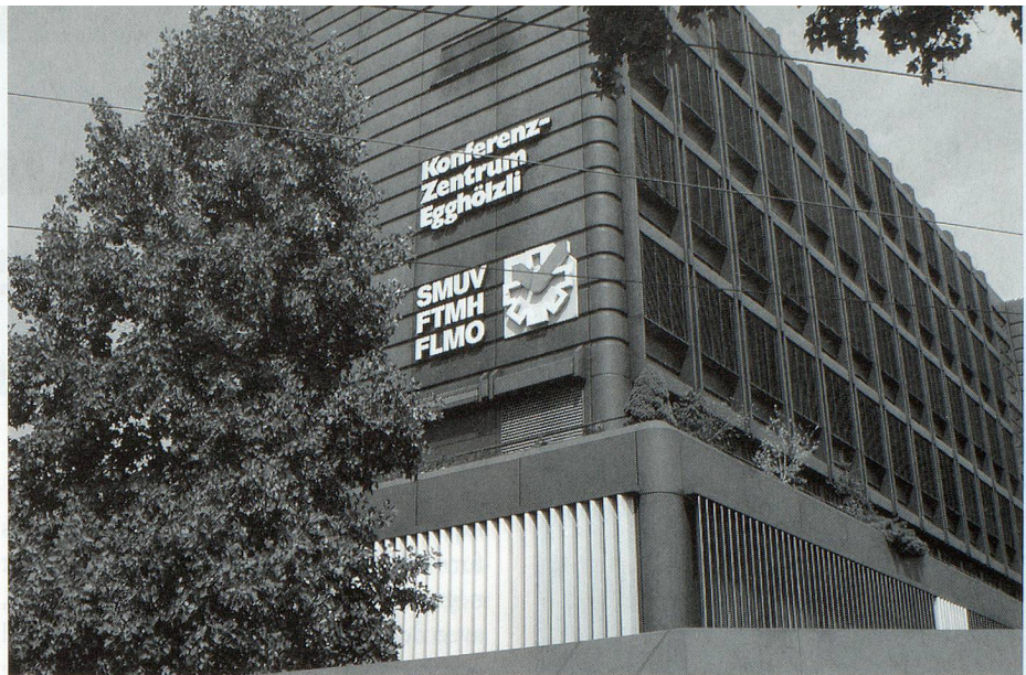
SMUV-Zentrale in Bern (Archiv-Standort).
