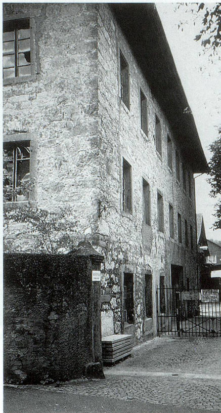
Das Manufakturgebäude der Firma Laué in Wildegg, erbaut um 1780, 1998 beinahe abgebrochen. Einer der wichtigsten Zeugen der Frühindustrie im Aargau.
