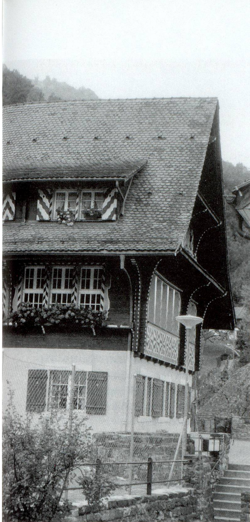
Renoviertes und umgebautes Schulhaus Bauen.
