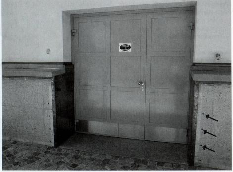
**Dans des endroits** où le risque existe, l'adoption de barrières anti-eau préparées à l'avance et à disposition près de la porte concernée, peut permettre d'annuler l'effet d'inondations provenant de l'extérieur, ou au moins d'augmenter le temps disponible pour l'évacuation des magasins. Ici les portes de l'Archivio di Stato à Bellinzona, avec les points de fixage des barrières antieau.
