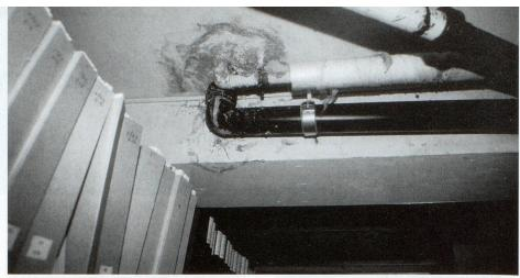
**Les canalisations** et conduites hydrauliques sont une source de danger permanant dans les dépôts. Ici les traces d'infiltrations d'eau sont bien visibles.
