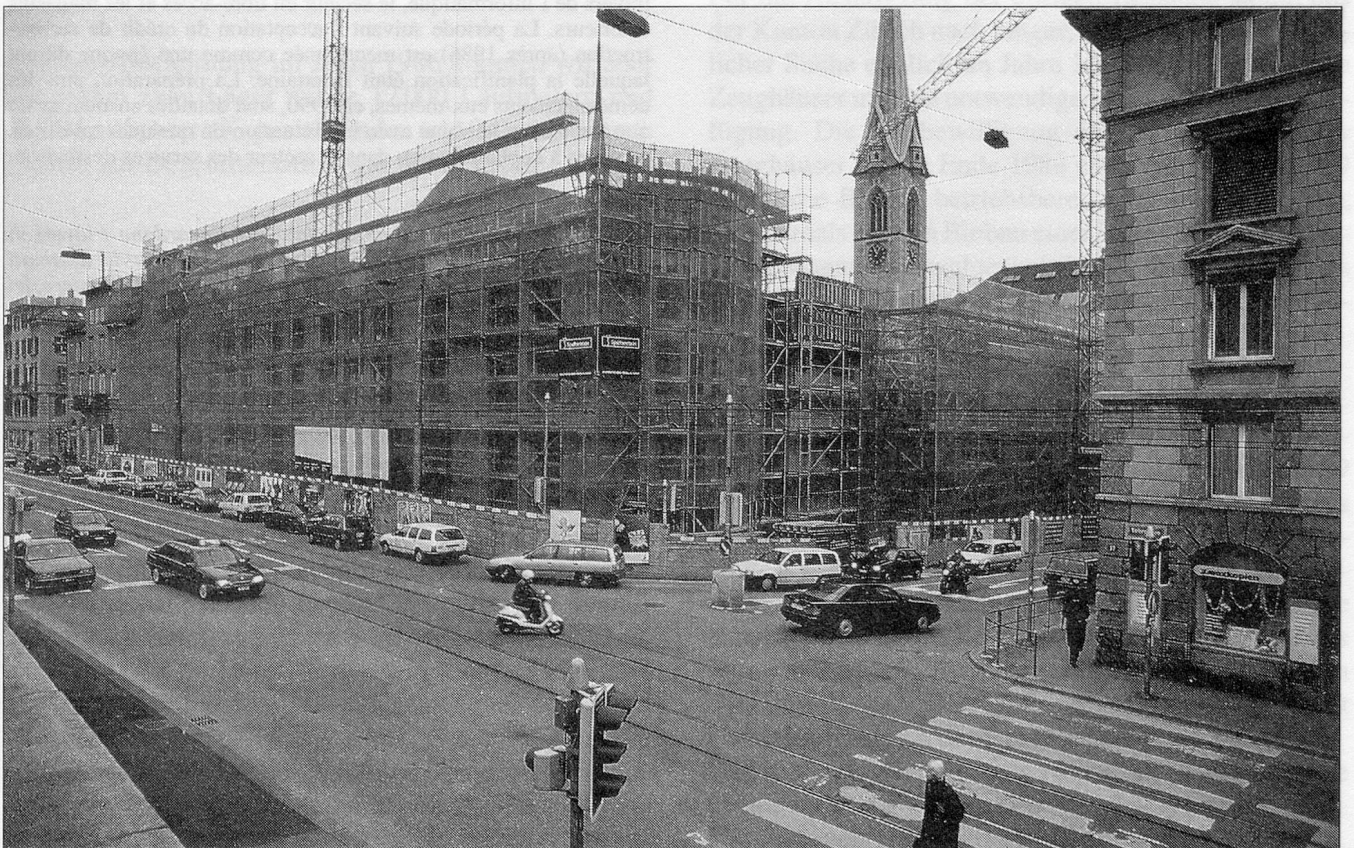
Aufnahme des Rohbaus Mitte Dezember 1992. Die Aufnahme wurde über den Seilergraben hinweg gemacht. Sichtbar sind Buchbearbeitungs- und Publikumstrakt mit dem Durchgang der Chorgasse zwischen diesen Teilen.
