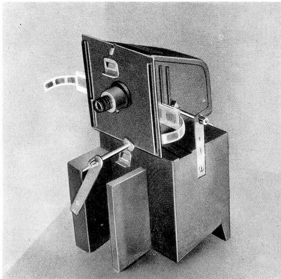
Ein einmaliges Umdrehen des Filmtransportknopfes bewirkt einen Vorschub von fünf 24/30 mm Aufnahmen, bzw. von zehn Buchseiten im Normalformat. Ein direkt unter dem Übersetzungsgetriebe angebrachtes Kardangelenk ermöglicht das Anhalten des Filmtransportarmes oder des Knopfes in jeder beliebigen Lage.
