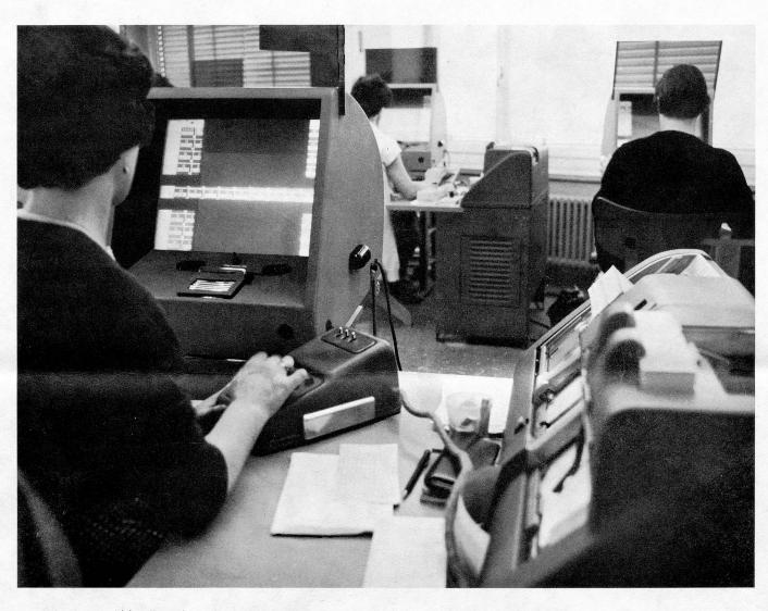
Abb. 2. Uebertragung der Mikrofilmaufnahme der Zählerstände der Telephonabonnenten auf Lochkarten; Lesegerät
