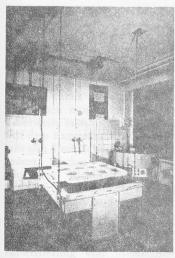
Abbildung 7: Rütteltisch zur Prüfung der Scheuerbeanspruchbarkeit.
