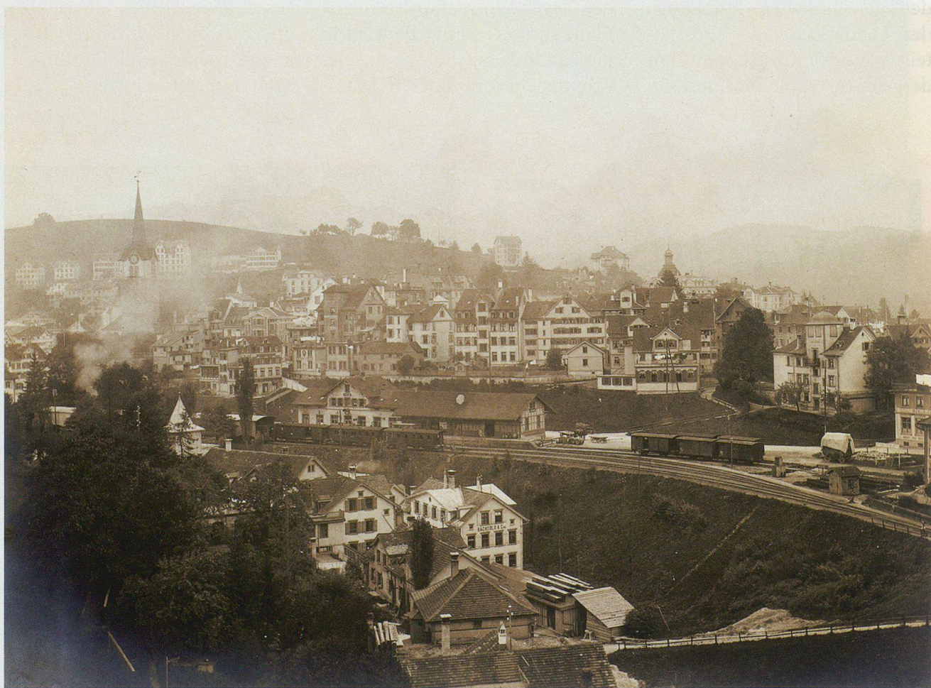
Die Ein- und Ausfahrt in die zentrumsnahe Station Herisau der Appenzeller Bahn geschah über das gleiche, von rechts kommende Gleis. Richtung Urnäsch–Appenzell fahrende Züge wurden zur Abweigestelle zurückgeschoben.
