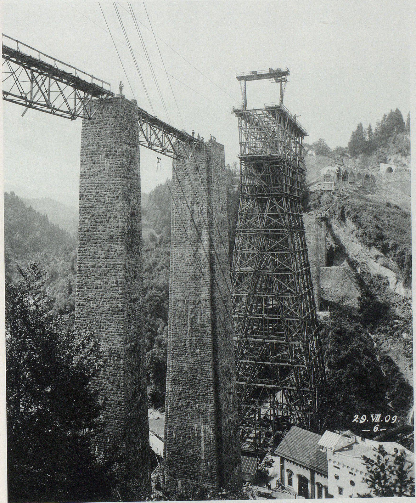
Der Bau des Sitterviadukts, der höchsten Brücke Europas, in Stein-Eisen-Konstruktion.
