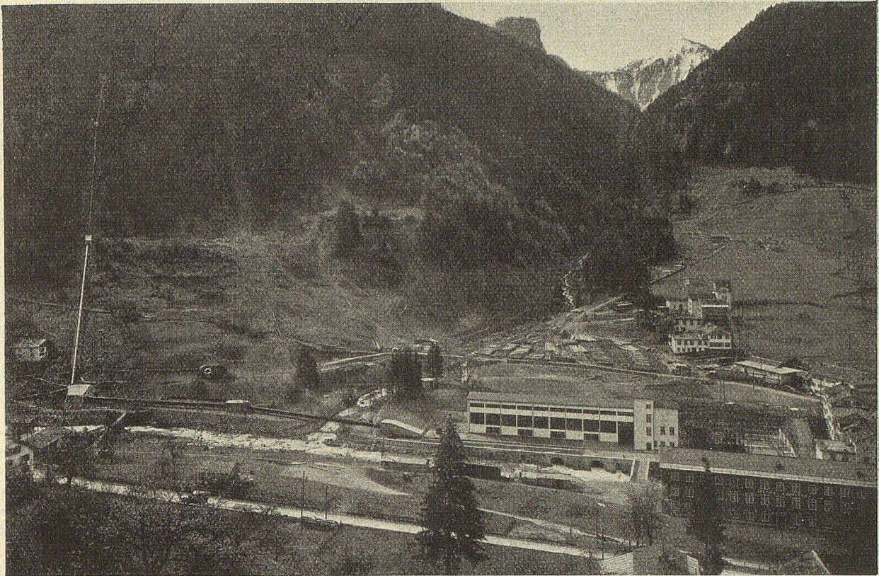
S. N.-Zentrale in Schwanden bei der Mündung des Niederenbaches in die Sernf. Links die Druckleitungen des Sernfwerkes und des Niederenbachwerkes. Rechts Freiluftstation mit abgehender Hochspannungsleitung.
