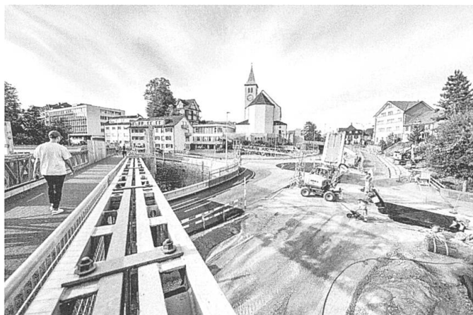
Verkehr zum Bahnhof Herisau fliesst wieder.
