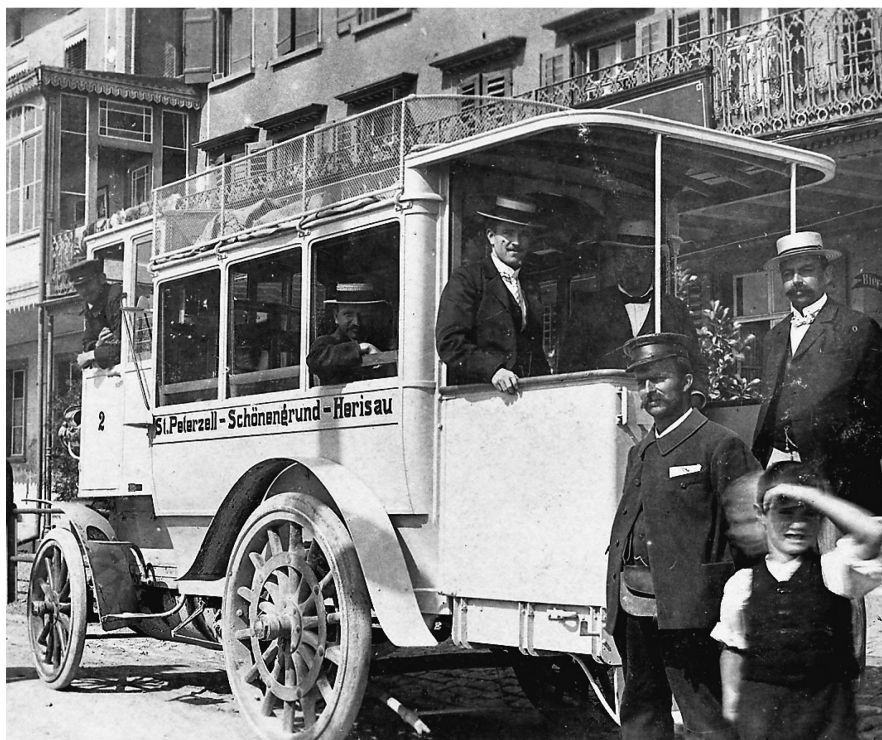
Fahrzeug Nr. 2 mit voll besetzter Plattform vor dem Kurhaus Hirschen in Waldstatt, wohl 1905.
