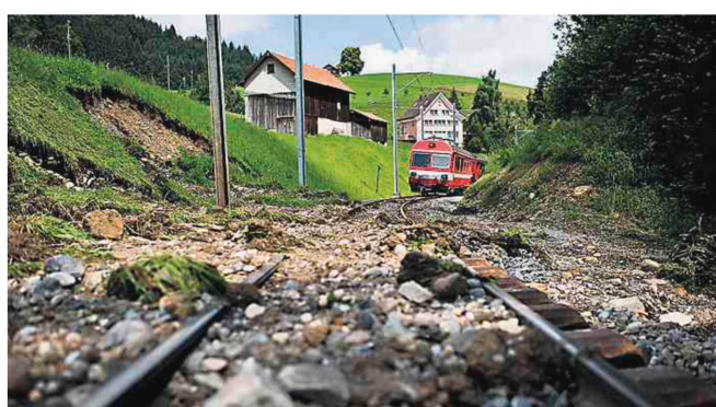
Die Bahnstrecke Herisau – Urnäsch wurde durch Unterspülungen stark beschädigt und blieb für Wochen gesperrt.
