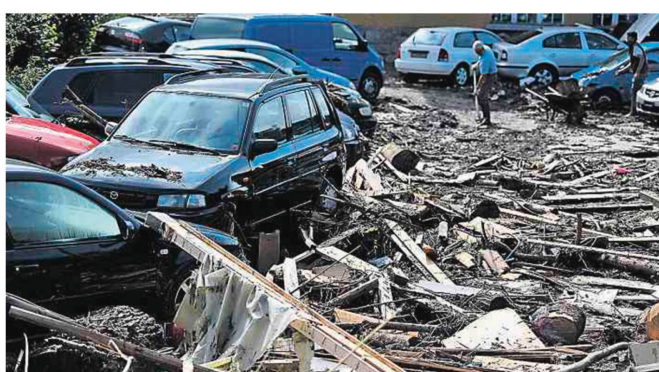
Das Unwetter hatte diverse Gewerbebetriebe an der Alpstein- und der Industriestrasse in Herisau in Mitleidenenschaft gezogen, wie hier eine Autogarage.
