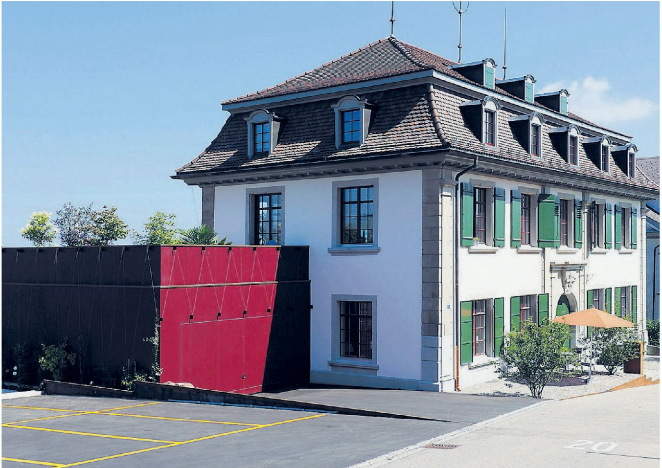
Das umgebaute Zeughaus in Trogen wird für Wohn- und Arbeitszwecke benützt. Für den Laien gewöhnungsbedürftig ist der an die Westseite angebaute Quader.
