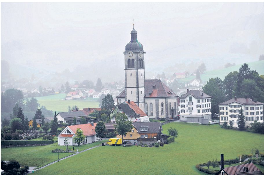
Gewittrig am Festwochenende wie vor 200 Jahren: 1804 schlug der Blitz in den Turm der Kirche Speicher ein, der sogleich Feuer fing; erst sechs Jahre später wurde der Neubau eingeweiht.
