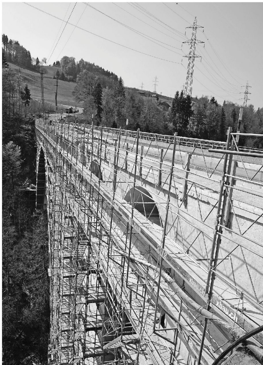
Sanierung im Jahre 2011.
