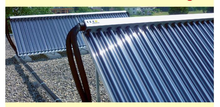
...mit den Star azzurro CPC-Vakuumröhrenkollektoren\*.
