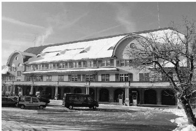
Das Zeughaus in Herisau wird zum Hauptquartier der Ausserrhoder Kantonspolizei umgebaut.
