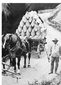
Seit 150 Jahren gute Strassen im Appenzellerland
