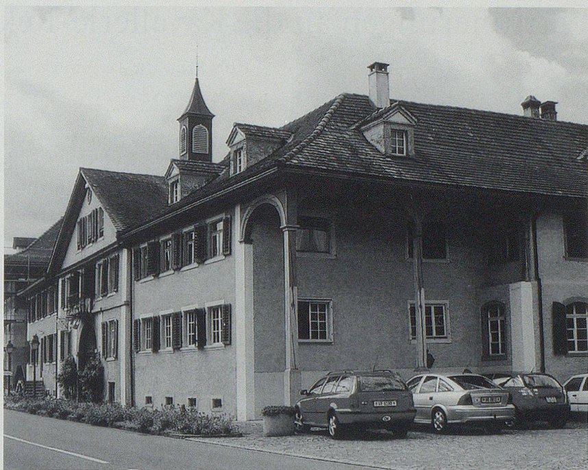
Südostfassade des Hauptgebäudes mit Glockenturm.
