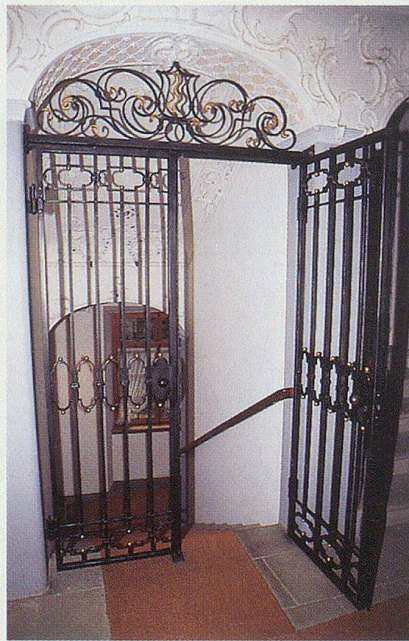
Ein Gittertor trennt das Treppenhaus des Pfarr- und Gemeindehauses am Trogner Landgemeindeplatz von den Räumen der Kantonsbibliothek.
