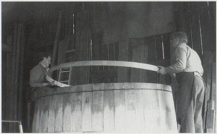
Während das Fass im Innern mittels Feuer erhitzt wird, spritzt der Mitarbeiter von aussen kaltes Wasser (oben). Das 5000-Liter-Fass wird zusammengefügt.
