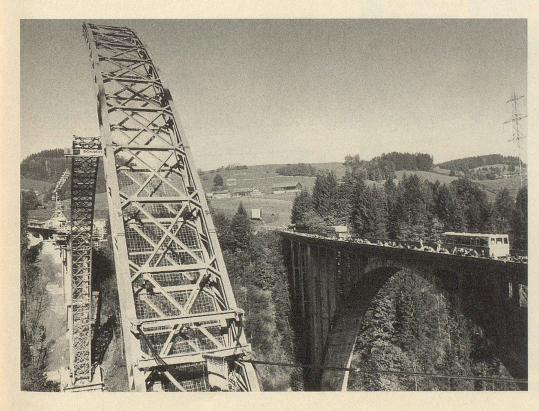
Der Bau der neuen Hundwilertobelbrücke mit dem eingeklappten bogenförmigen Stahllehrgerüst.
