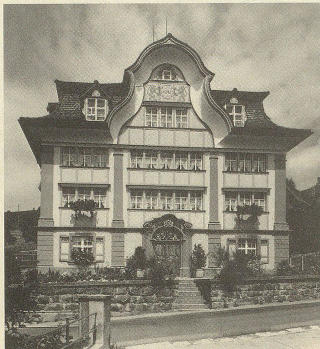
Gais. Fabrikantenhaus (Nr. 177) 1783/1784 für Landessäckelmeister Jakob Gruber im barocken Stil erbaut. Einheimische Zimmermannskonstruktion (Strickbau) und traditionelle Reihenfenster sind eine vornehme Verbindung eingegangen mit europäischen Stilformen des Barock und Rokoko.
