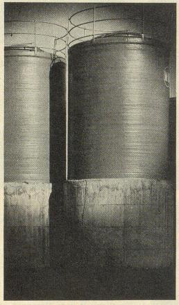
MWB-Aufsatzsilos auf Beton-Bodensilos
