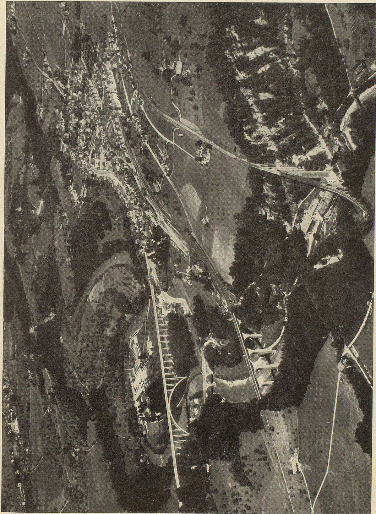
Übersicht über das Brückenmuseum im Sittertobel. Links oben die neue Fürstenlandbrücke, unten die alte steinerne Kräzerenbrücke, dann das Eisenbahnviadukt der SBB, dasjenige der Bodensee-Toggenburg-Bahn und unmittelbar rechts davon die beiden alten Hüslibrücken, über die sich einst der ganze Verkehr abwickelte. (Fliegeraufnahme Hans Groß — Aero St. Gallen.)
