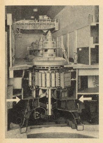
Querschnitt durch die Zentrale am Modell. Unterhalb der beiden Pfeile die Turbine einer Maschinengruppe mit dem Laufrad. Darüber der Stromerzeuger und oberhalb des Maschinensaals bodens Tragbalken, Spurlager und Erregermaschinen.
