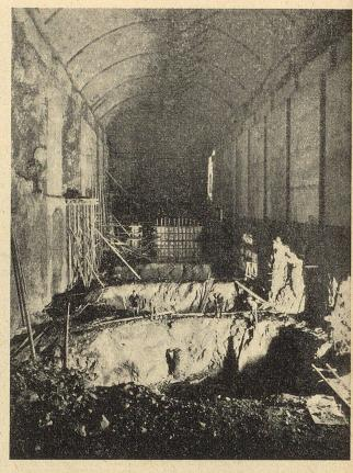
Blid in in die Maschinenhaus-Kaverne während der Bauzeit. Dede und Wände zum Schutz gegen das berausbrechen und Seruntersallen von Steinen bereits betoniert, Zwischenhöden und Zwischenwände des Maschinenhauses aber noch nicht eingezogen.
