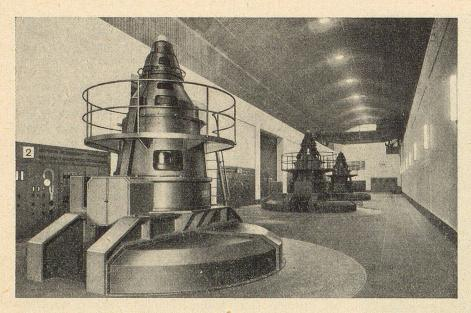
Innenansicht der Zentrale mit den drei vorläufig eingebauten Maschinengruppen und ihren Bedienungs= und Kontrollinstrumenten.
