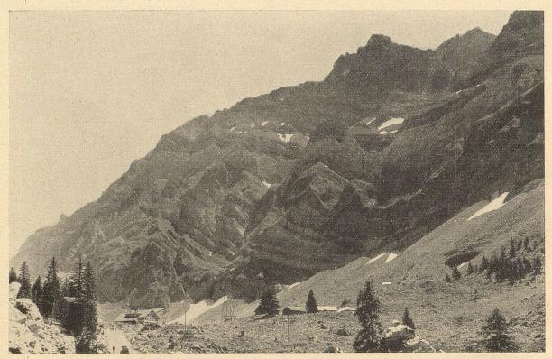
Die Talstation der S. S. B. auf Schwägalp. Links im Vordergrund die neue Zusahrtastraße und das Bahnhosrestaurant mit der Einsahrtshalle. Rechts die 50 Meter hohe Stütze I und die Tragseile, die über Stütze II auf die auf dem Kamme sichtbare Stütze III führen. (Phot. Abderhalden, Herisau).
