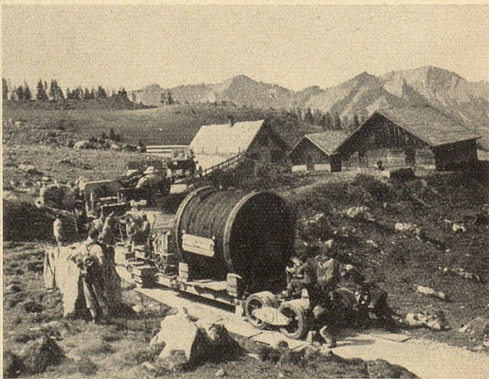
Tragseiltransport auf die Schwägalp. Es mußten vier solcher Seilrollen im Gewicht von je 600 Zentnern auf einem schmalen Aufsträbchen über kleine Brülllein und viel steilere Hänge als auf dem Wilde sichtbar ist, von Herisau nach der Talstation befördert werden. Der Transport der ersten Seilrolle erforderte nicht weniger als drei Wochen. (Aus dem Baufilm von G. Abderhalden, Herisau.)
