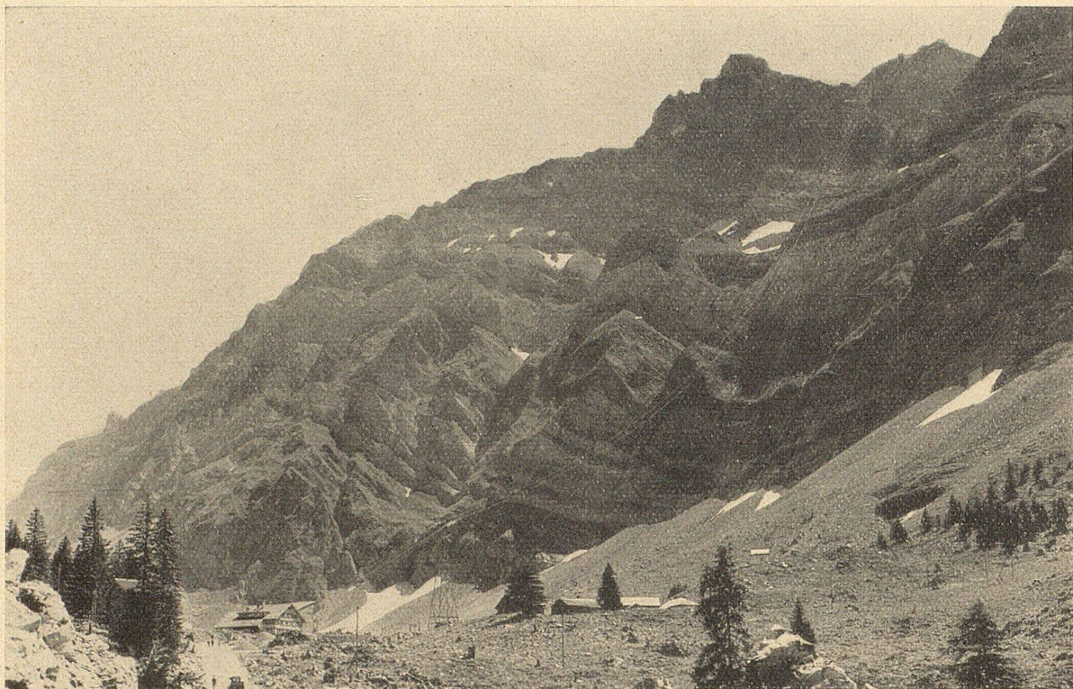
Die Talstation der S. S. B. auf Schwägälp. Links im Vordergrund die neue Zufahrtsstraße und das Bahnhofrestaurant mit der Einfahrtshalle. Rechts die 50 Meter hohe Stütze I und die Tragsäule, die über Stütze II auf die auf dem Kamm sichtbare Stütze III führen. (Phot. Alderhalben, Herisau).
