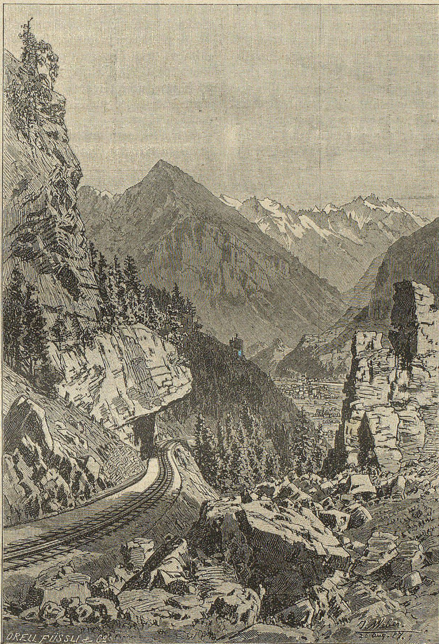
Bei der Großbachbrücke gegen Meiringen.
