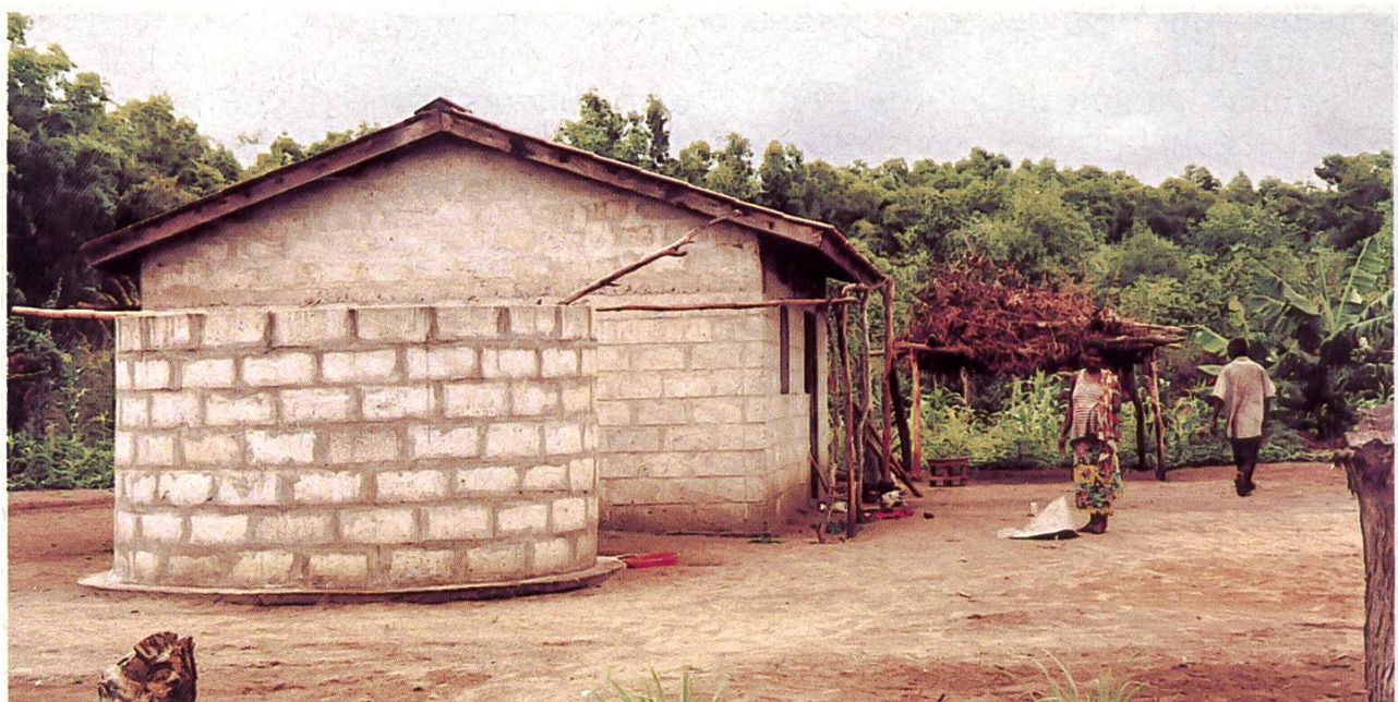
Ferme actuelle avec réservoir pour l'eau.
