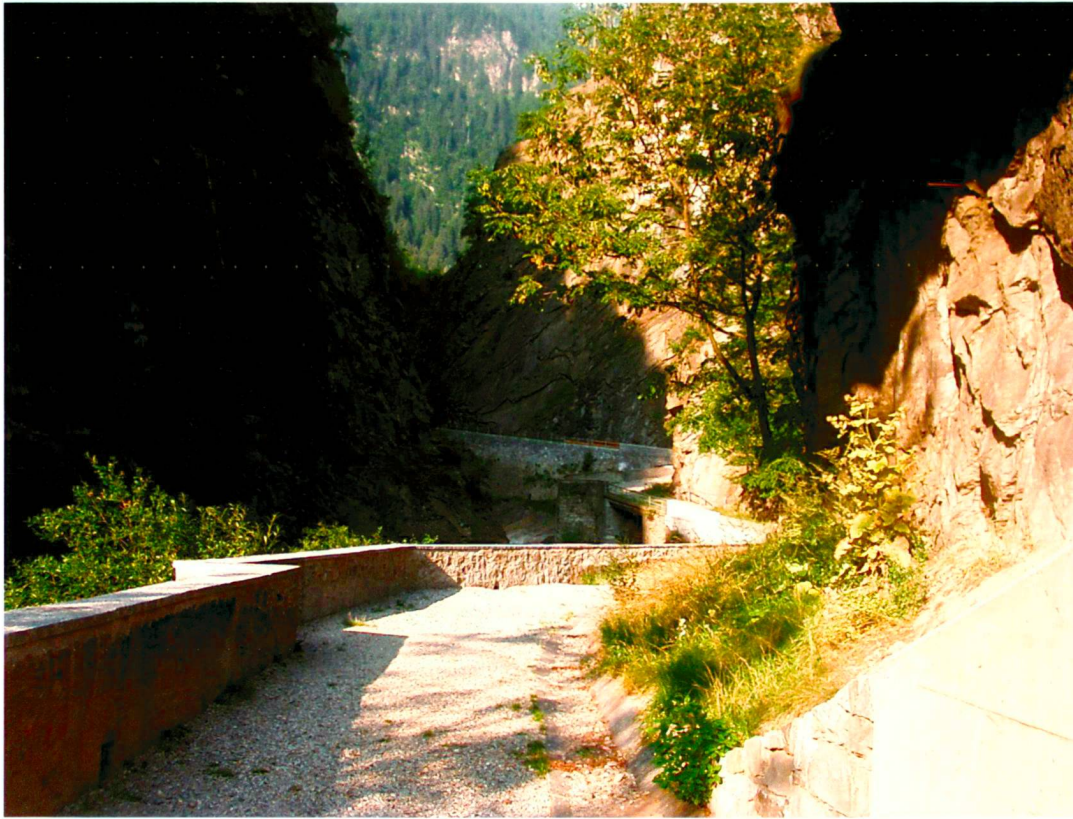
Der restaurierte Weg durch die Piottino-Schlucht.
