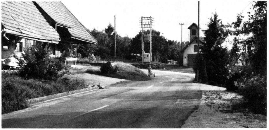
A gauche: Il faudrait renoncer à un éclairage exagéré pour se contenter de lampes plus discrètes, permettant de s'orienter, par exemple aux coins des maisons.
