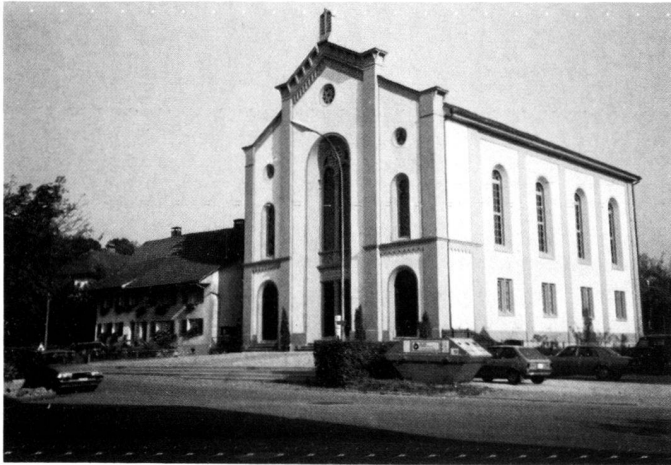
Die Synagoge, erbaut 1847. La synagogue, construite en 1847. Synagogue, built in 1847.
