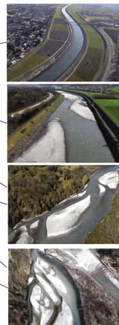
Rhesi Hochwasserschutz Alpenrhein, IRR (3)
