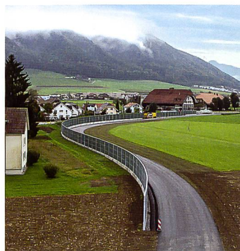
Umfahrungsstrasse zum Flughafen Bern-Belp
