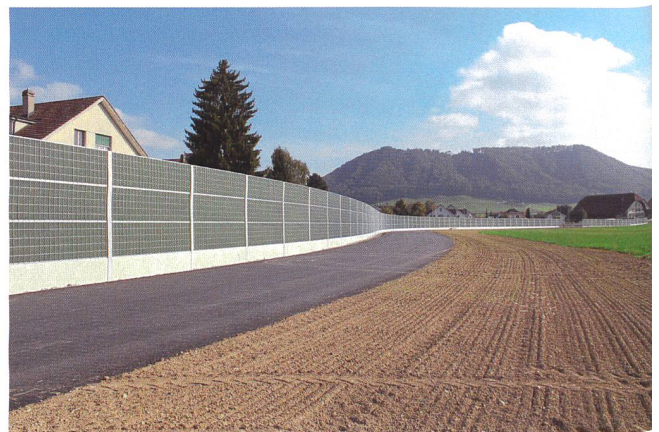
Hochwertiger, ästhetischer Lärmschutz an der Umfahrungsstrasse zum Flughafen Bern Belp.
