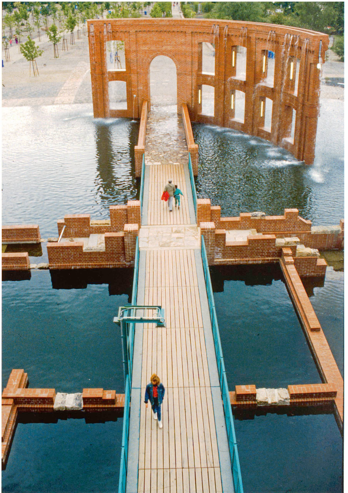
1 Mauerscheibe im Wasser auf der Hafensinsel in Saarbrücken. Hybrid aus Antike und Industriezeitalter.
