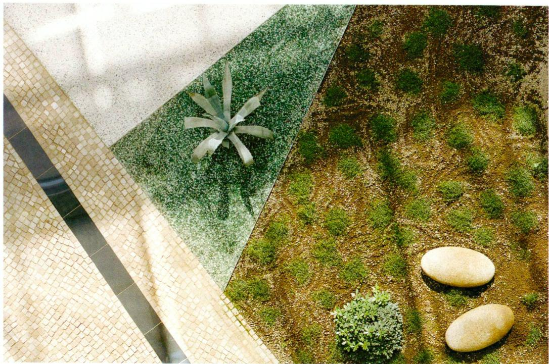
Die Gründächer verbessern die Gebäude temperierung. Überschüssiges Dachflächenwasser wird in Zisternen gespeichert und zur Bewässerung der Beete im Atrium genutzt, was Energiekosten zur Wasserbereitstellung einspart.
