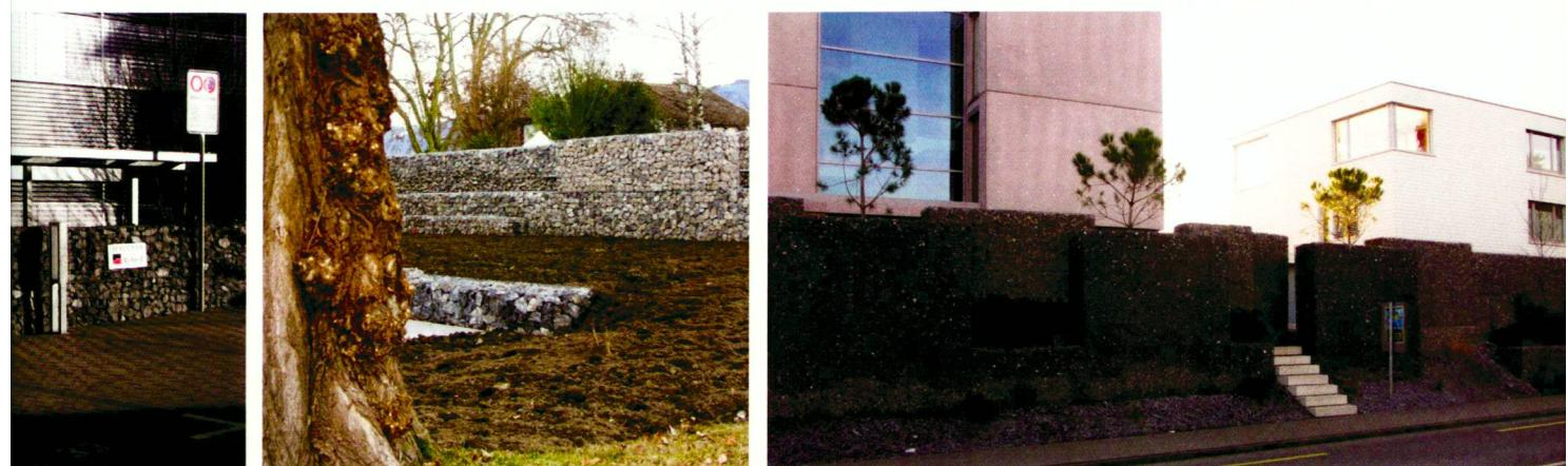
facher ist. Aus statischen Überlegungen ist in solchen Fällen statt mit einem Anzug besser mit Rückversatz zu arbeiten. Kurven und Winkel sind mit vorverfüllten Körben nur bedingt möglich. Bei Richtungsänderungen entstehen zwangsläufig keilförmige Fugen.
