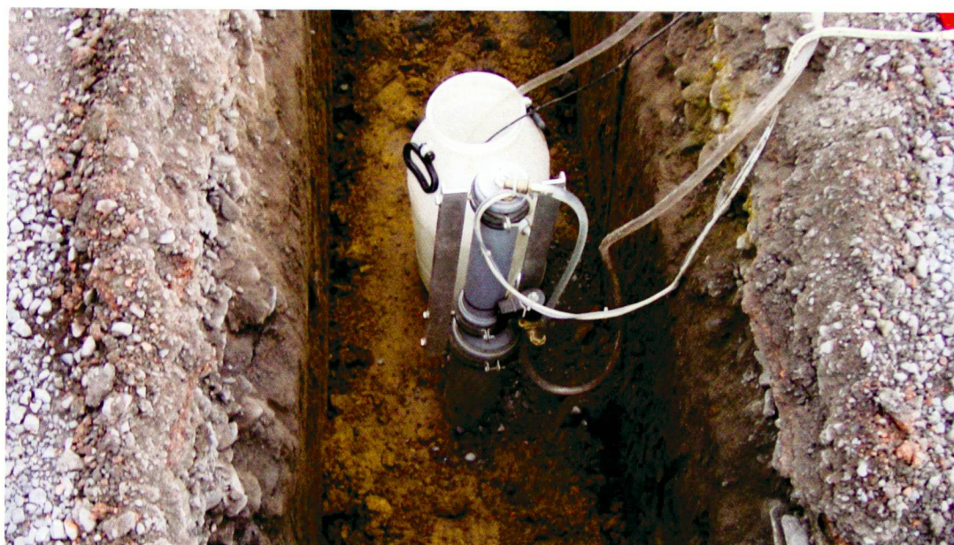
Bestimmung der Wasserdurchlässigkeit nach dem Open-End-Verfahren.
