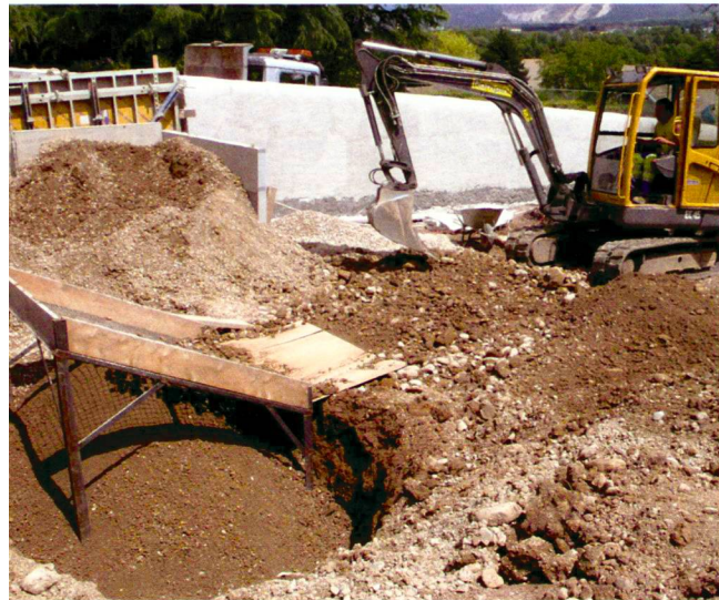
Der gesiebte Lehm wird mit Kies gemischt. Terre tamisée puis mélangée à du gravier.
