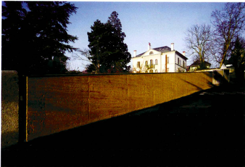
Wieder hergestellte Mauer. Réhabilitation des murs.
