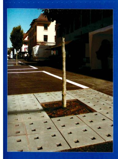
Der neue modulare Baumgrubenunterbau für Beton-, Gitter- und Gussabdeckungen
