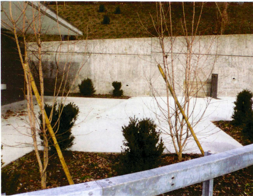
Zugangsort zum Toilettenhäuschen.
