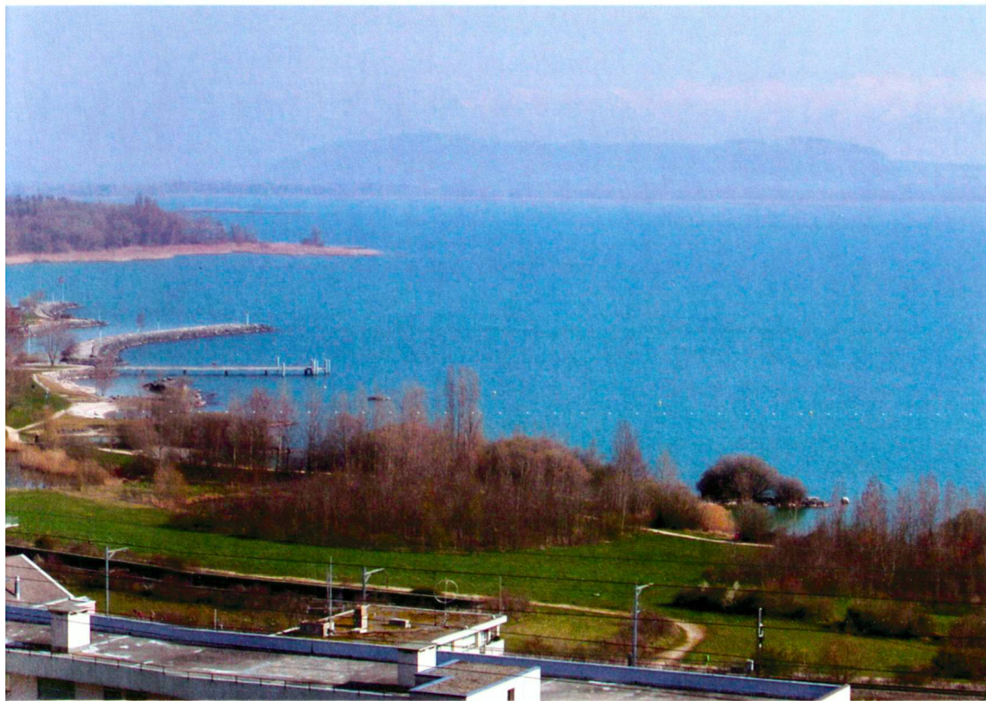
Neugestaltung des Ufers des Neuenburgersees zwischen Hauterive und St-Blaise.
