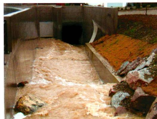
**Hochwasserentlastungsbauwerk bei erhöhter Wassermenge: links die Öffnung für den offenen Bachlauf, rechts der Einlauf in den unterirdischen Kanal.**
