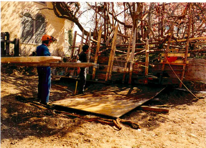
Nach maschinellen Bohrungen unter dem Ballen wurden Stahlseile durch die Öffnungen vorgetrieben. An den Seilen wurden mittels Seilwinden Stahlplatten, zwei mal vier Meter gross, gezogen, deren Verlängerung jeweils an Ort und Stelle angeschweisst wurde. Gleitschuhe verhinderten ein Überschieben der Platten. Der gesamte Wurzelballen wurde so mit 80 Quadratmetern Eisenplatten unterlegt.
