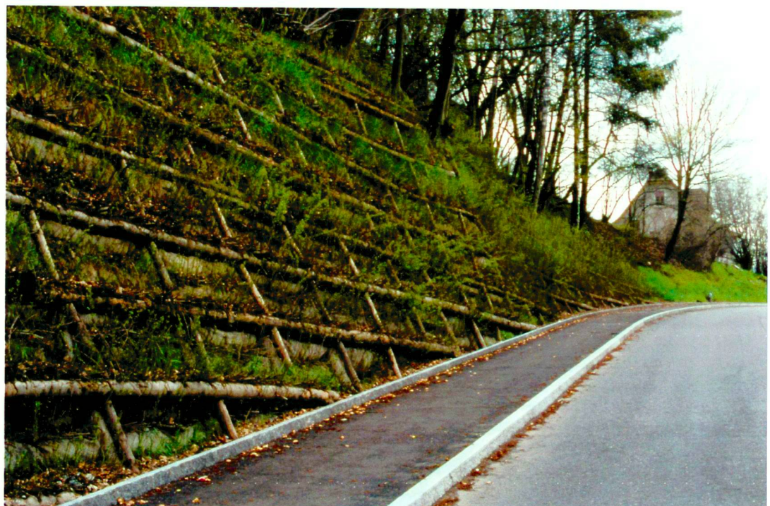
Hangverbauung Villmergen: Böschungssicherung mit lebendem Hangrost statt Betonmauer. Büro Stöckli und Kienast, Wettingen.
