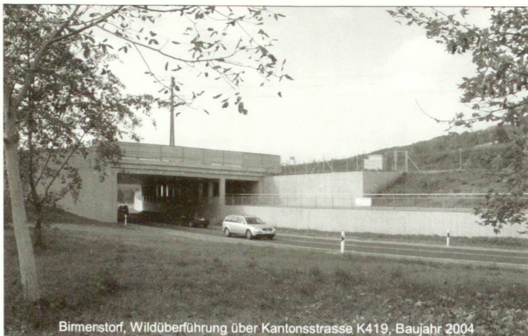
Birmenstorf, Wildüberführung über Kantonsstrasse K419, Baujahr 2004
